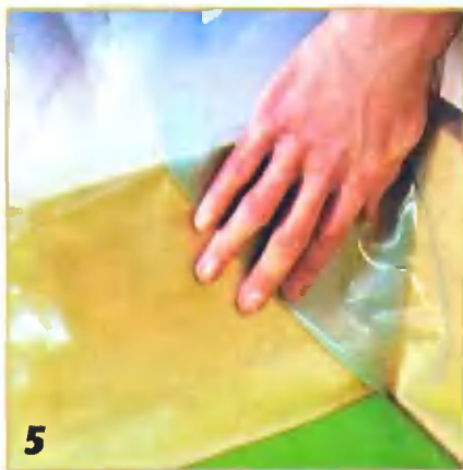
5 В углах пленку складывают в треугольники.
