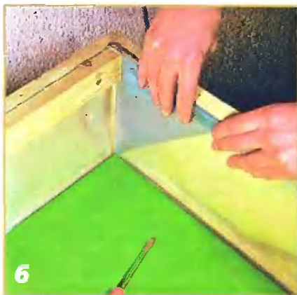
6 Множественно подвернутую пленку прикрепляют к одному из боковых элементов и отгибают треугольник в сторону.
